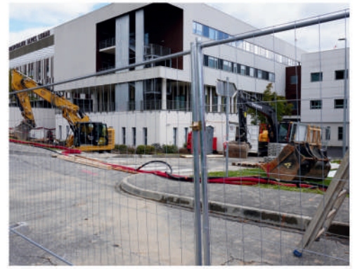
DÉBUT DES TRAVAUX D'EXTENSION DU PLATEAU TECHNIQUE
