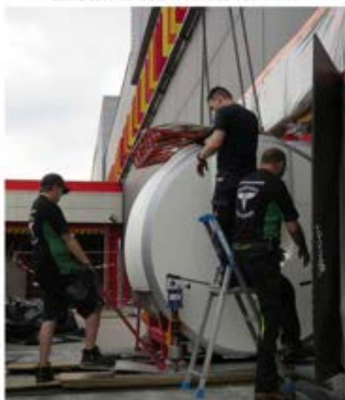
INSTALLATION DE L'IRM MAGNETOM SOLA 1,5T
