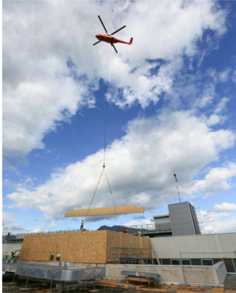
TRAVAUX DU SELF PAR HÉLIPORTAGE À FINDROL
