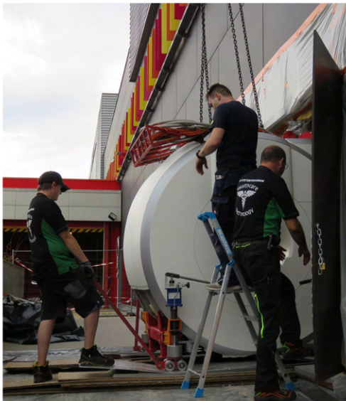
INSTALLATION DE L'IRM MAGNETOM SOLA 1,5T
